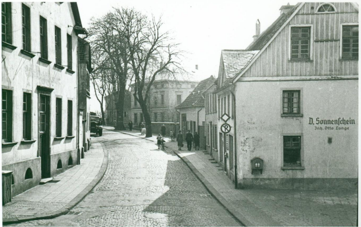
Abb. 20: In dem links zu sehenden Gebäude Hochstraße 17 war von 1869 bis 1899 das Lüdenscheider Krankenhaus untergebracht, gleich schräg gegenüber von Boeckers Wohnhaus. Das Bild entstand um 1930.
