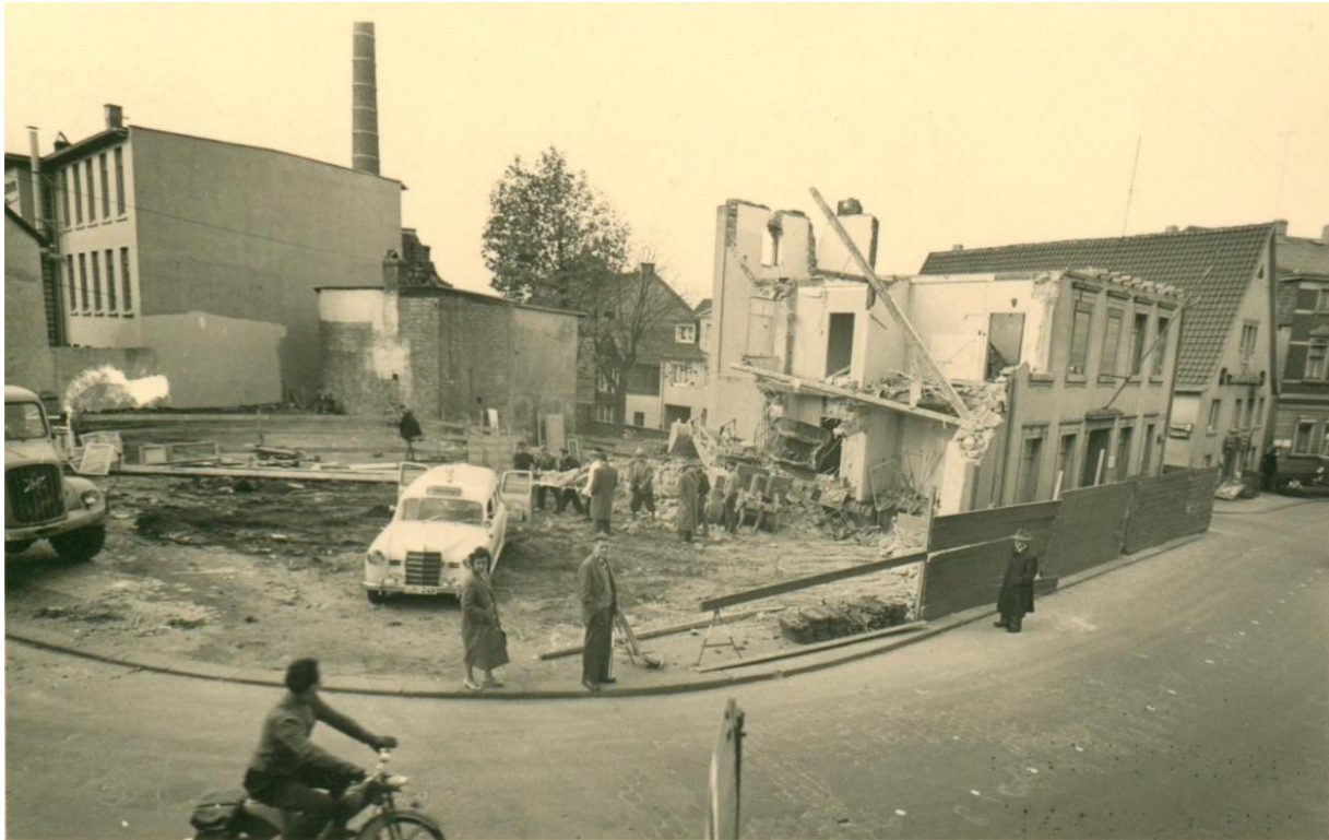
Abb. 14: Abriss des Hauses Hochstraße 20 im Jahre 1959.
