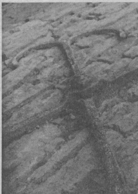
Neuer Ankertyp mit moderner Halteform mittels gestauchten Nietkopfes, deren vierfache Irmisul-Form größere Fläche hielt. An den Stellen, wo der Schmied im Feuer Formänderung (Loch, Spaltung, Endung) anzubringen hatte, befinden sich Kerbzeichen. Diese Anker gehen meist nicht durch die Mauer, sondern sitzen nur außen.
