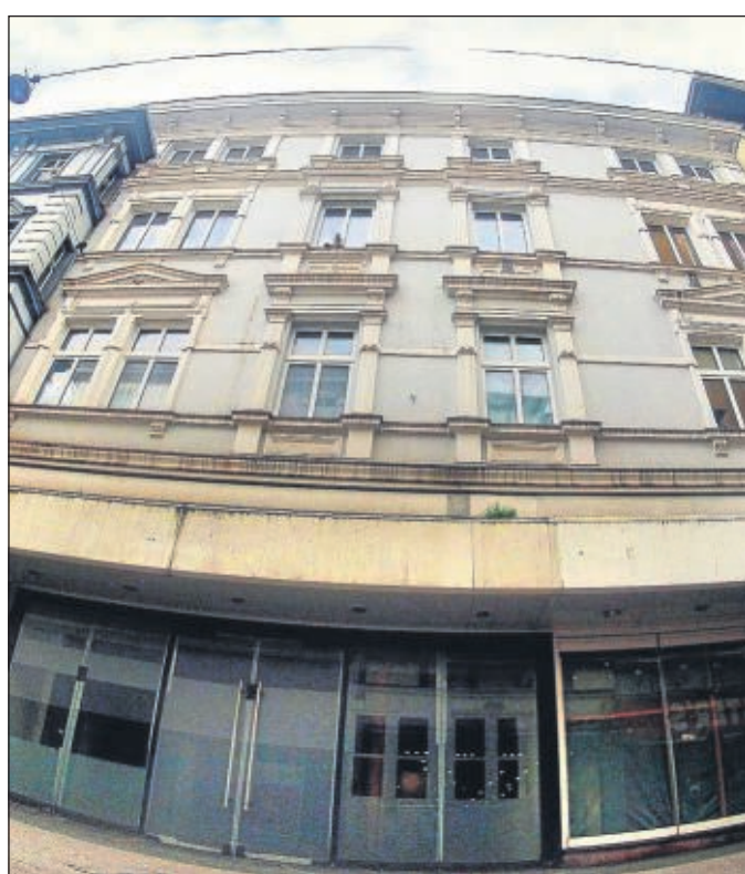
Die Fassade des Hauses soll erhalten bleiben. ■ Foto: Nougriगत
