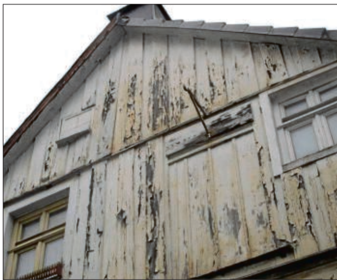
Manche Häuser im Quartier – so an der Marienstraße – wirken etwas marode. Hier könnte ein Fassaden-Programm greifen.
