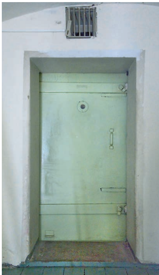
Abb. 3) Tür einer Arrestzelle im Keller des Alten Rathauses.
