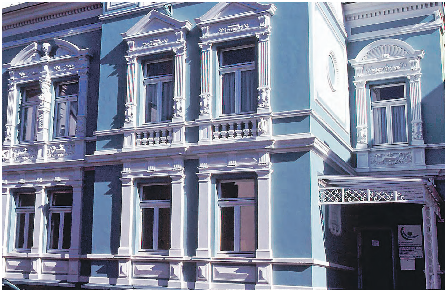
Abb. 13. Fassade des denkmalgeschützten Hauses Lessingstraße 15. Foto Hartmut Waldminghaus 22. Mai 2010.
