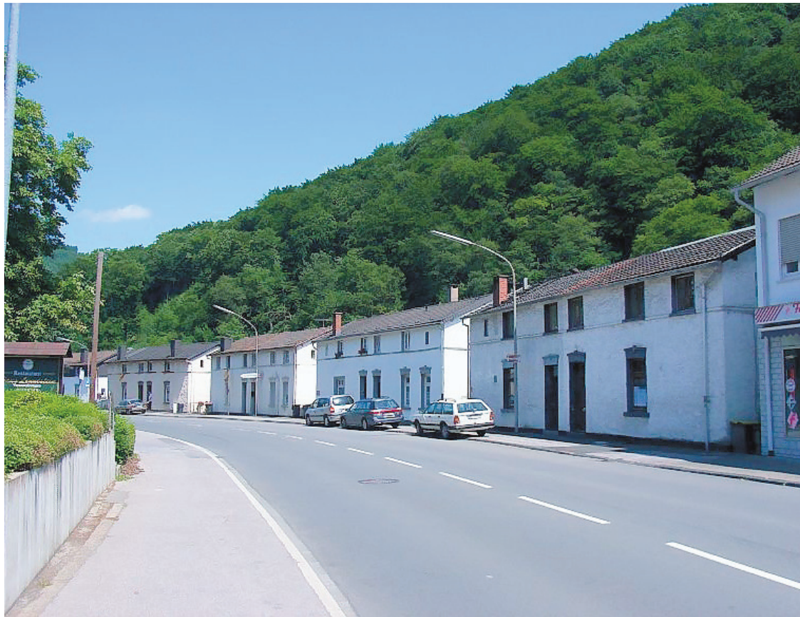
Abb. 6: Ehemalige Arbeitersiedlung in Altena, Werdohler Straße, errichtet gegen 1870. Aufnahme 2008 R. Stremmel.
