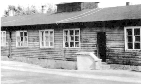
Gebäude der Baracke Buckesfelder Straße
