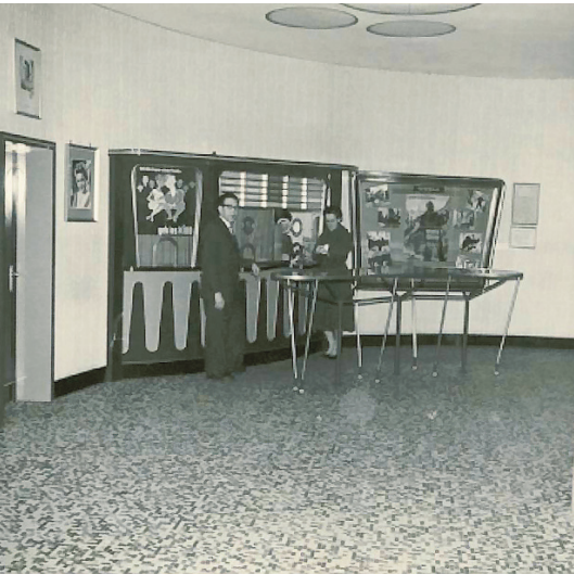
Innenansicht Foyer, Aufnahme 1956
