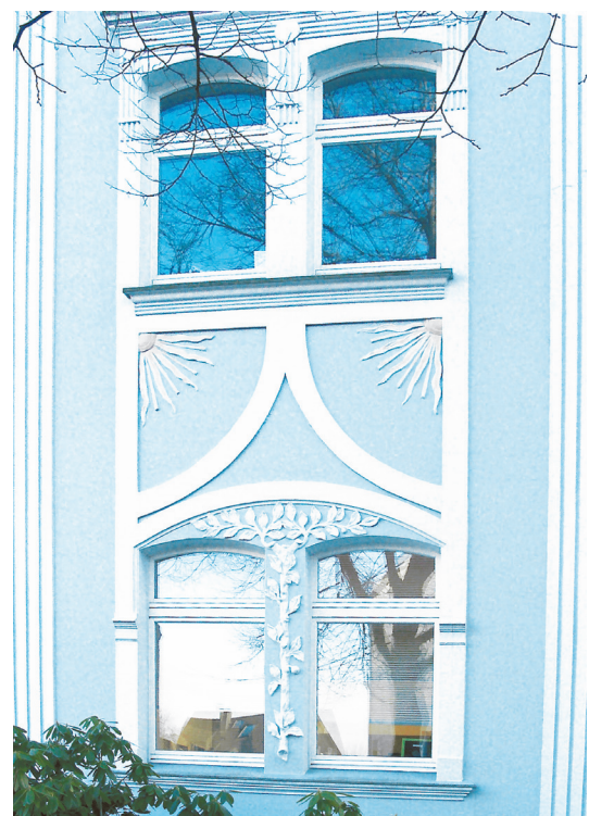
Fensterdetail Straßenseite, Aufnahme 2007
