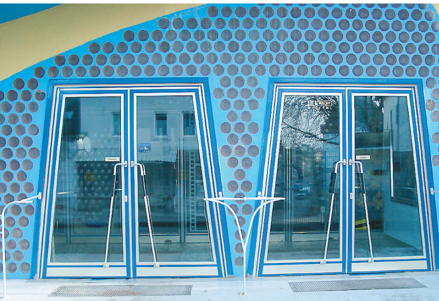
Eingangstür Detail, Aufnahme 2007
