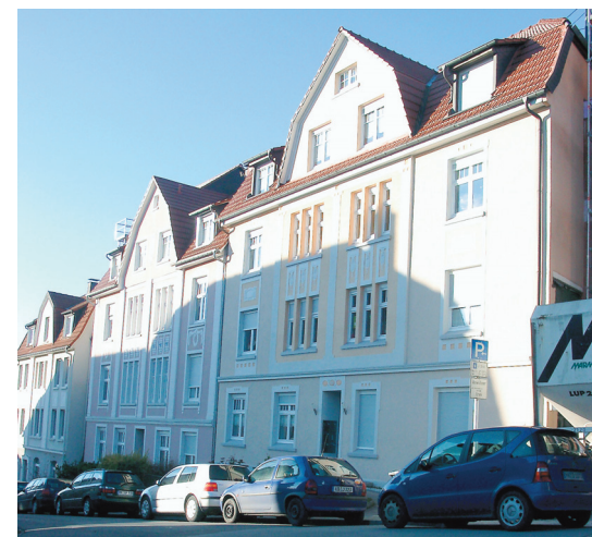
Straßenansicht Haus Nr. 4/6, Aufnahme 2007
