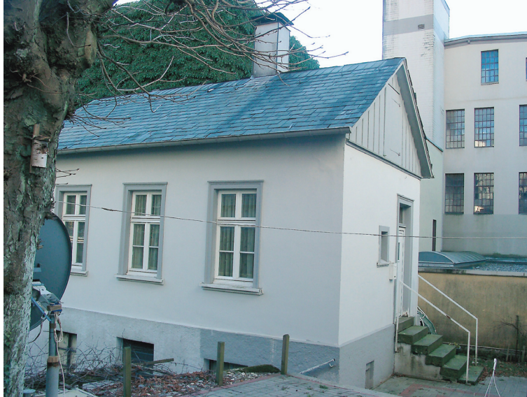
Hintergebäude, ehemals Graveurwerkstätte, Aufnahme 2007
