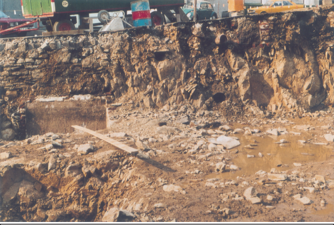
1976 Baugrube der Parkpalette im südlichen Teil der Altstadt, Blick von Süden. Lbld. R. A. (DIA-Abzg.)
