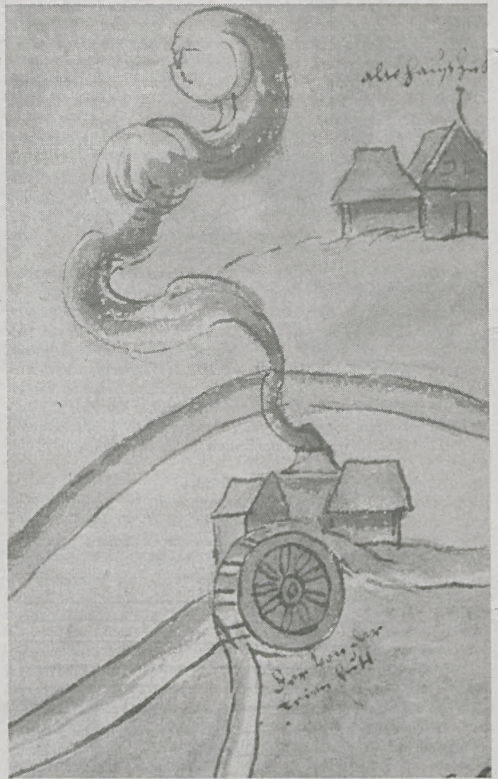
"Der von der Leyen Hutt" bei der ehem. Wasserburg Unterkaltenbach, Engelskirchen, im Besitz der Familie von Neuhoof-Ley. Älteste Darstellung einer Massenhütte in der Grafschaft Mark, mit Flossfen und überschlächtigem Wasserrad für die Blasebälge. Ausschnitt aus der Karte, die 1581/82 im Zuge eines langjährigen Rechtsstreits um das Kaltenbacher Bergbauggebiet gezeichnet wurde (Hauptstaatsarchiv Düsseldorf).
