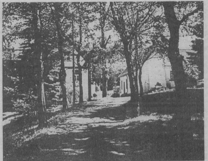
Gebäude Nr. 1 und 2 (1949)
