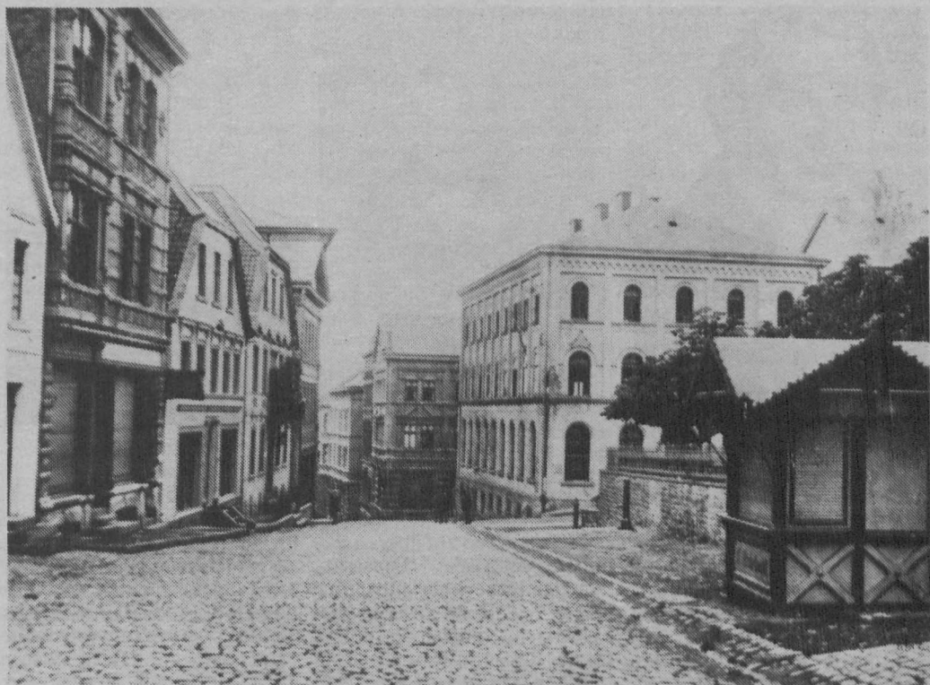
Historische Ansicht der oberen Wilhelmstraße: Hier wurde Gustav Nottebohm in dem Haus oberhalb der heutigen Adler-Apotheke geboren.
