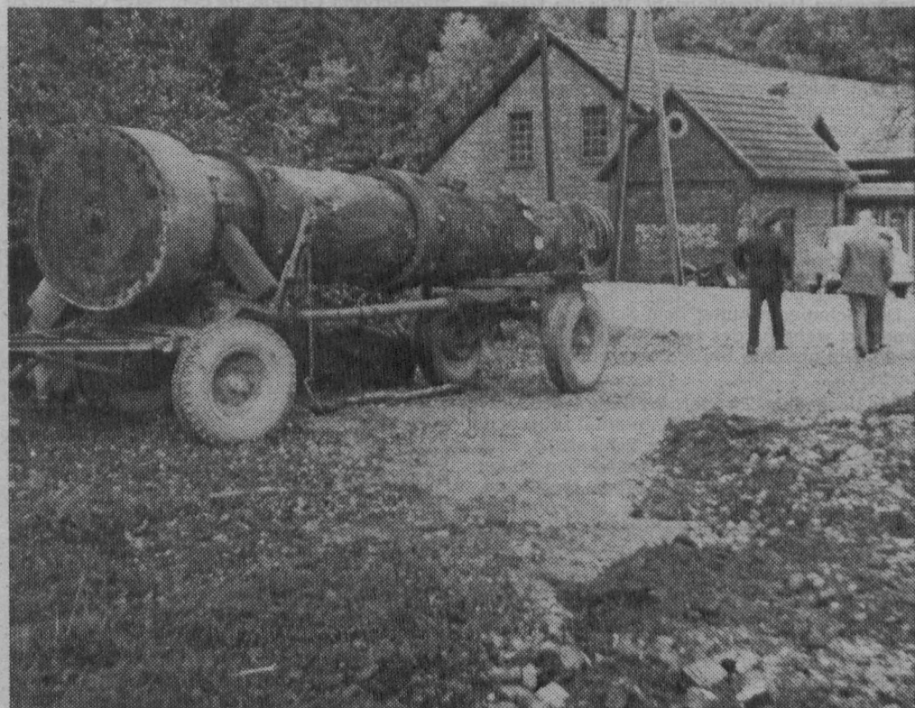
Transport der großen Hammerwelle zum Einbau in den Bremecker Hammer. Das Bild ist im Besitz der Stahlwerke Plate.
