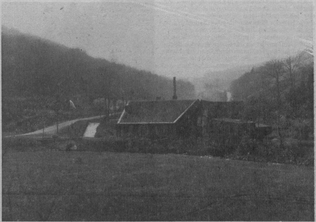
Zustand des Hammers vor der Jahrhundertwende. Noch steht der ursprüngliche Reckhammer. Daneben wurde bereits ein modernes Fabrikgebäude errichtet. Der alte Hammer ist in der Manier des Bruchsteinbaues errichtet, wie sie Jahrhunderte hindurch geübt wurde. Die Fabrik des 19. Jahrhunderts mit ihren großen Fenstern bevorzugt den Backstein. Foto Stahlwerke Plate.
