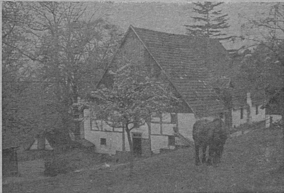
Hof Wesselberg. Einer der ältesten Höfe unserer Heimat. Das Deelentor ist zugemauert; weitere Kennzeichen der Bauweise: Verbretteter Giebel und Fachwerk über steinernem Sockel.
