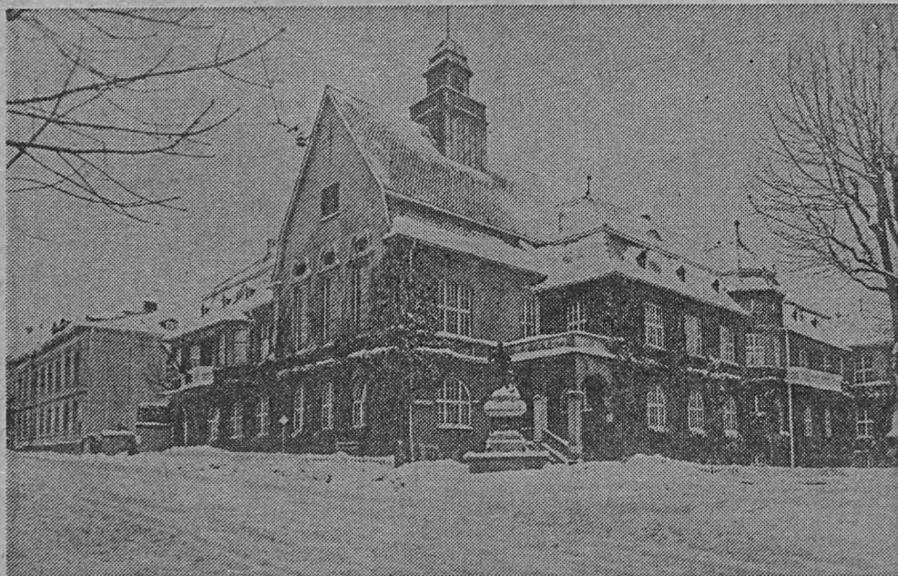
Ehemaliges Amtshaus — gleichzeitig Sitz der Verwaltung der Gemeinde Lüdenscheid-Land.
