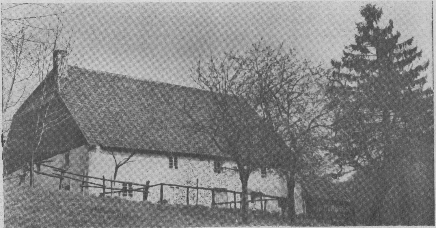
Pachthof des Neuenhofes in Altenlüdenscheid
